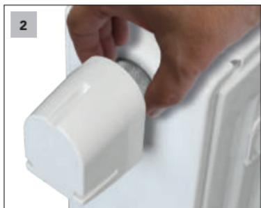
2) Draai vervolgens de wartelmoer (ring) op de aandrijving M 30 x 1,5 mm) met de „hand“ naar het ventiel.
